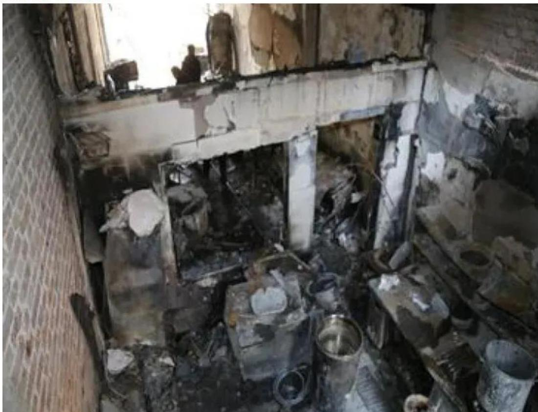
上虞区曹娥街道小陈小吃店发生一起瓶装液化石油气泄漏爆燃较大事故，**造成3人死亡**，经调查，事故直接原因系**店主在未关闭瓶阀状态下更换液化石油气钢瓶（该瓶无自闭阀），违规操作导致液化石油气泄漏。爆泄气体遇距离1米处的明火（在使用中的煤饼炉）后发生爆燃**，引燃室内可燃物致使灾情迅速扩大。
