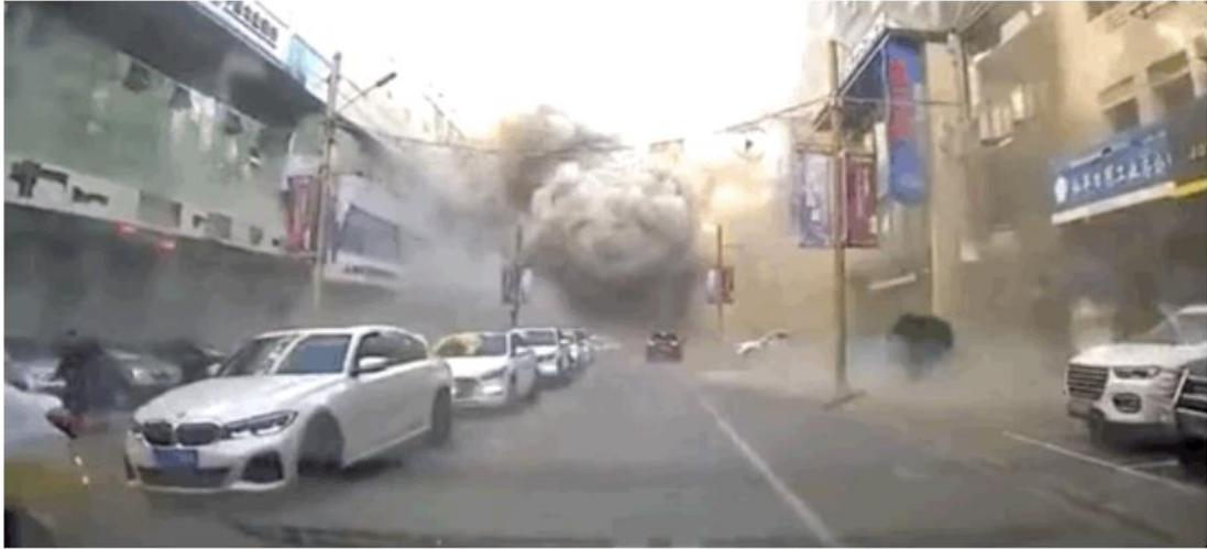
和平区发生爆燃，造成5人死亡、1人受重伤、46人受轻伤。经初步调查，在市政燃气管道改造施工时，由于施工人员违章操作造成管道系统泄漏，燃气在餐馆内聚集到爆炸浓度后，遇点火源产生爆炸。事故还暴露出燃气改造工程违法转包等严重违法违规问题。
