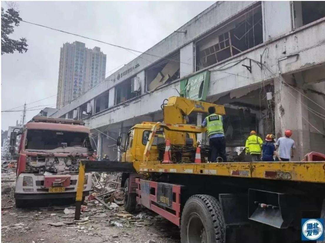
张湾区艳湖社区的集贸市场发生重大燃气爆炸事故，造成**26人死亡、138人受伤**，直接经济损失约5395万元。调查报告显示，事故的直接原因为**天然气中压钢管严重腐蚀导致破裂**，泄漏的天然气在集贸市场涉事故建筑物下方河道内密闭空间聚集，遇餐饮商户排油烟管道排出的火星发生爆炸。
